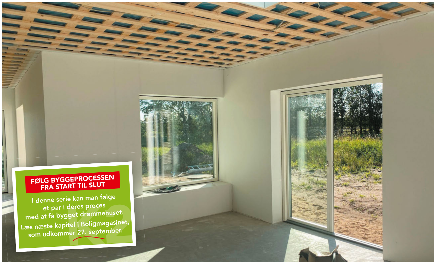
Væggene i huset på Åbrynet i Tulstrup er nu blevet spartlet, pudset, filtet og ikke mindst malet første gang. Foto: Privatfoto
